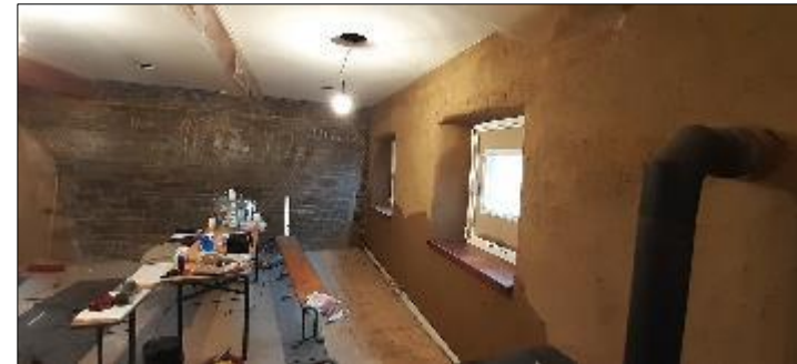
Dämmung der Innenwand mit Lehm
