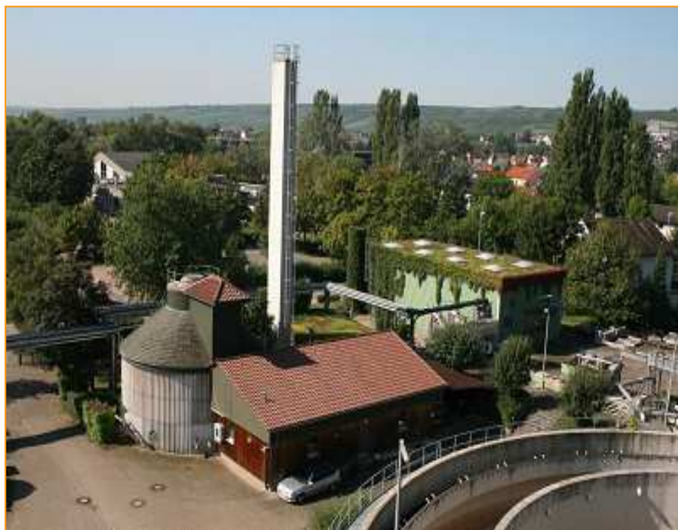
Blick auf Kläranlage Oppenheim
