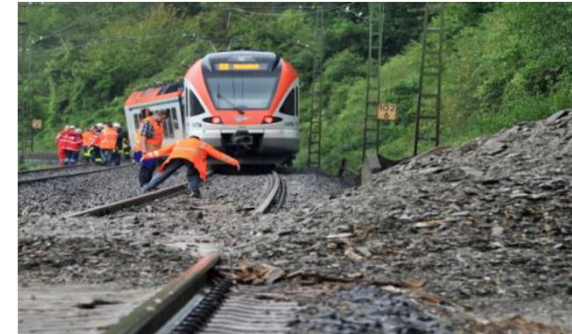
Erdrutsch und Zugentgleisung, Kestert Quelle: WAZ, .6.8.2011, Zug nach Starkregen im Rheintal entgleist
