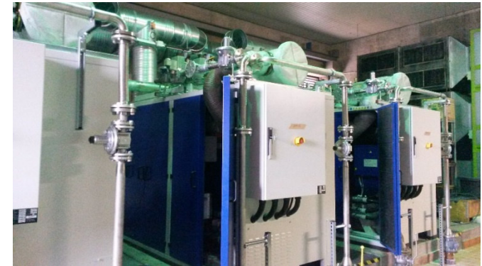
Blockheizkraftwerk, Klärwerk Koblenz-Wallersheim (Ziegler, 2015)
