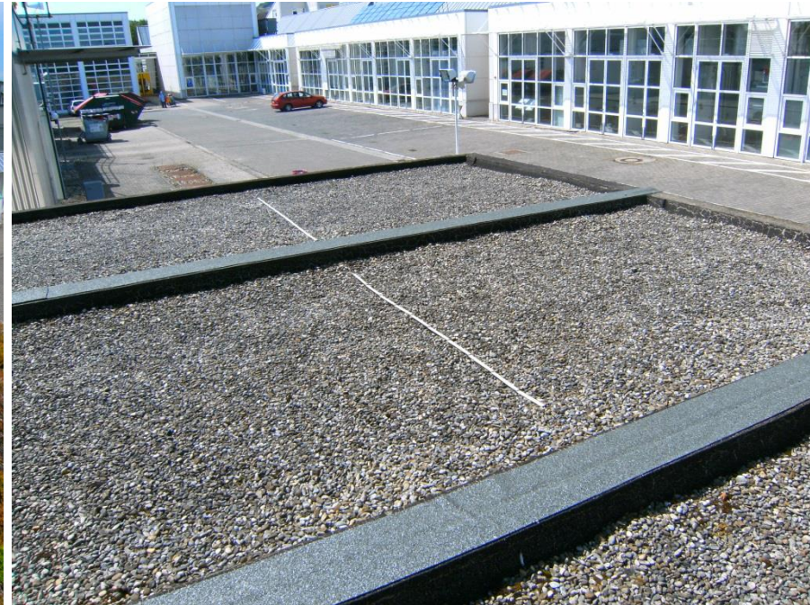
Kiesdächer: Bitumen-Dachpappe und 3 - 5 cm Kiesschicht
