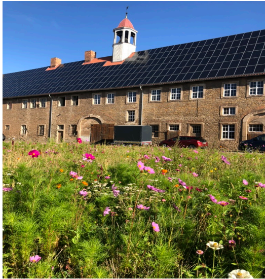
Sonnenschloß Walbeck Denkmal +PV
