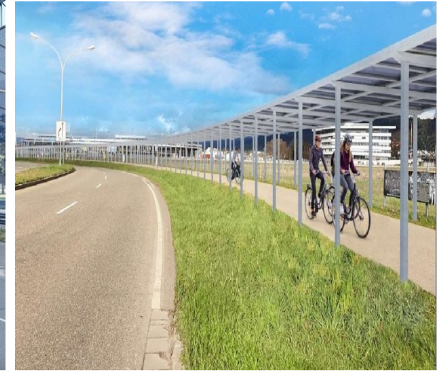
PV Überdachung Radschnellweg Freiburg
