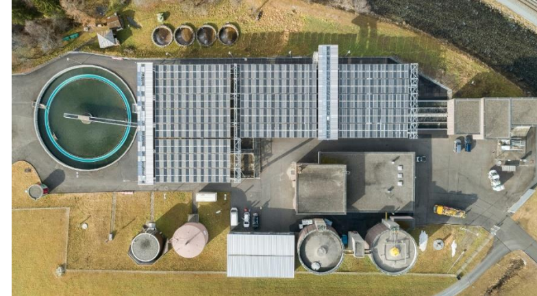
Beispiel: solares Faltdach für die Kläranlage Davos
