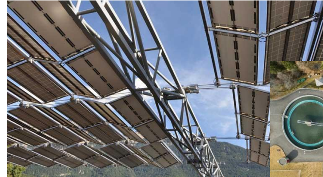
Beispiel: Faltdach der Kläranlage ARA Chur
