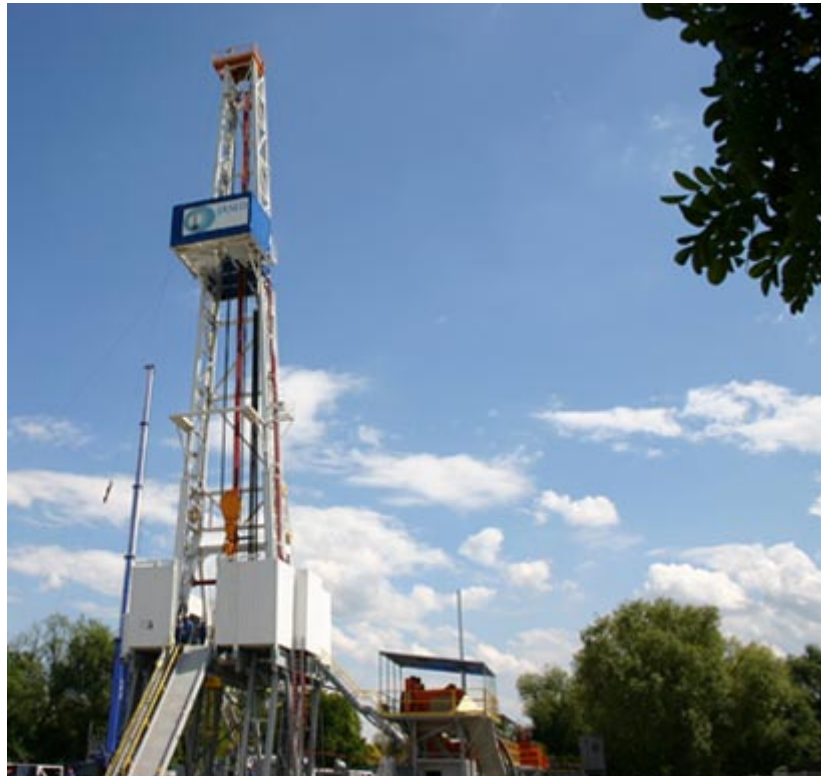
Abbildung 1-1 Bohrturm in Landau (Quelle: Institut für Energetik und Umwelt GmbH)
