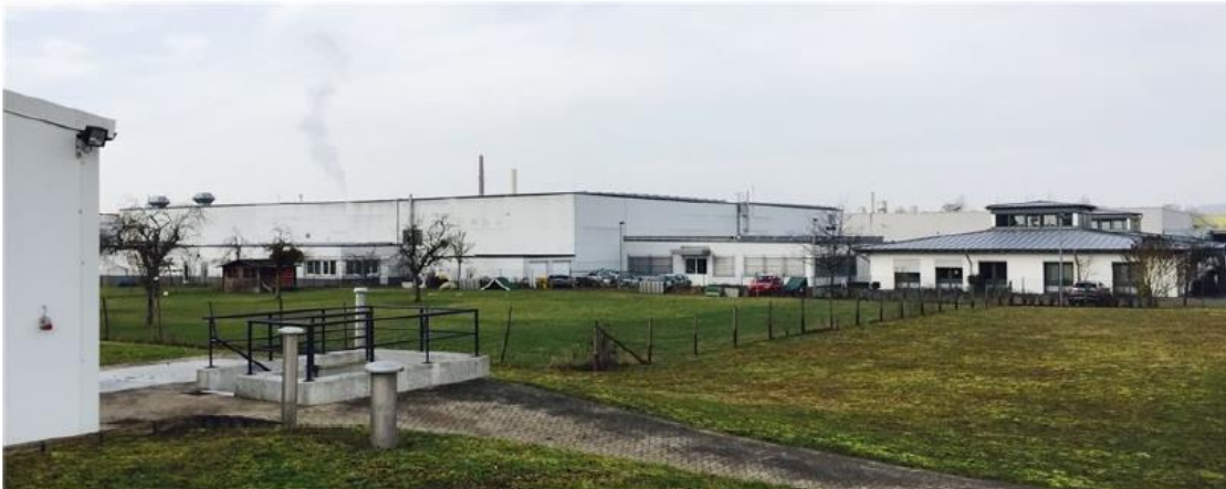
Der zukünftige Standort der Photovoltaik-Anlage in Sinzig. Stadt Sinzig
