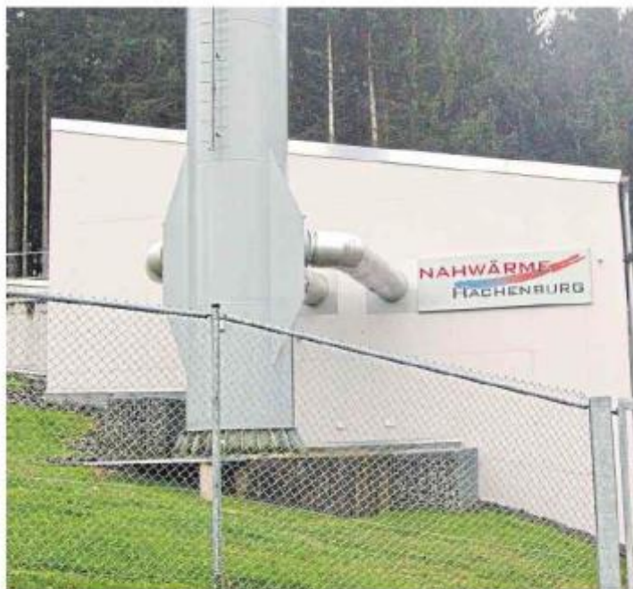
Das Nahwärmenetz ist eines der bisherigen Vorzeigebauwerke in Sachen Klimaschutz in der Verbandsgemeinde Hachenburg. Nach dem Willen des VG-Rates sollen bald weitere Leuchtturmprojekte folgen. Foto: Nadja Hoffmann-Heidrich
